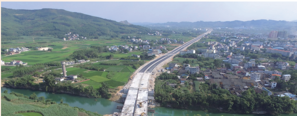
广西分行支持的柳州市沙塘至沙埔道路改造工程
