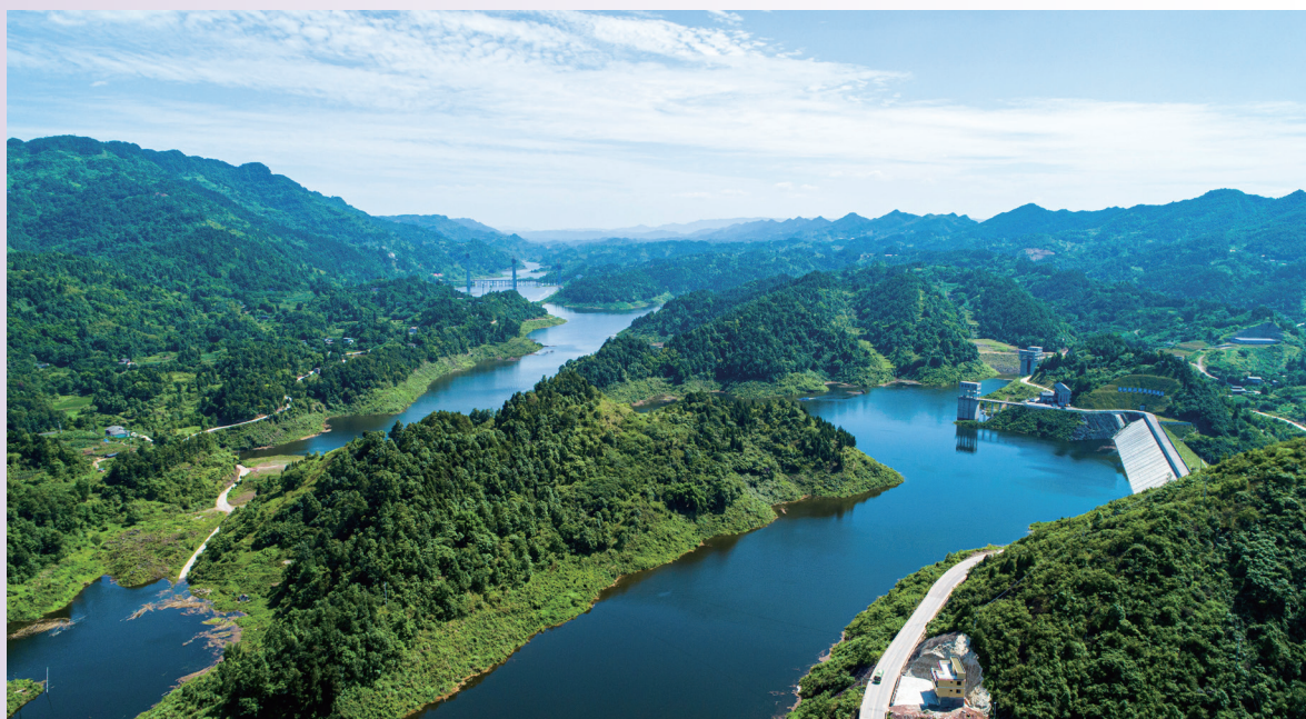
重庆分行支持的观景口水利枢纽工程项目
